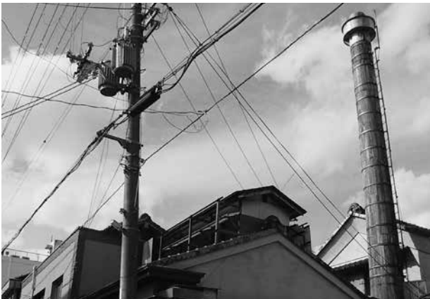
図6 棟部分の開口部と巨大な煙突
