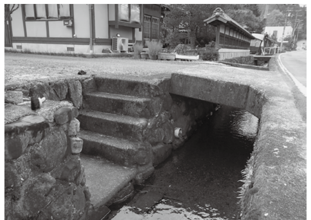
図 38 民家と道路の間を流れる水路沿いの洗い場（イトヤ）
