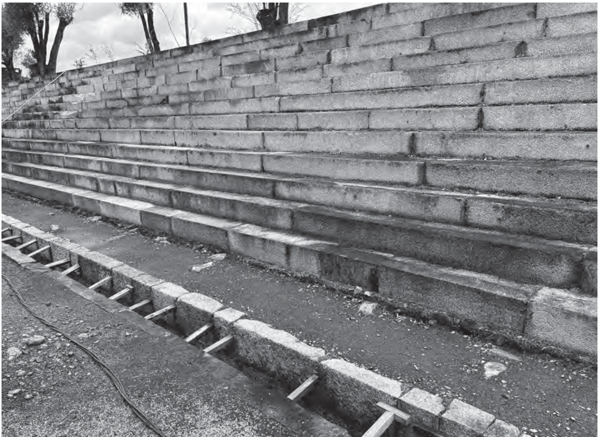
図31 本丸北雁木裾における控え石の検出状況（南東から）
