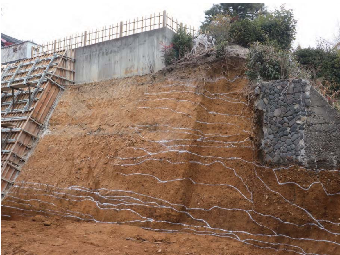
2 IV - 5 伏見城跡 (24A009) No.4～6 遠景 (南西から)
