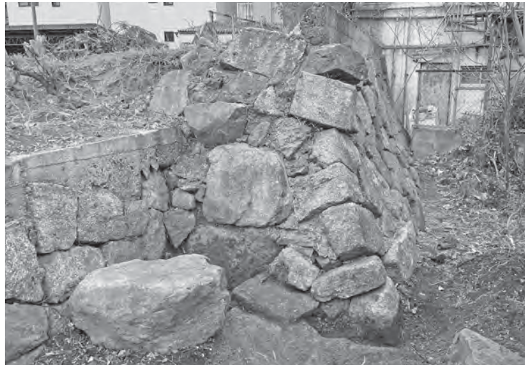
図 87 張出部北面石垣(北西から)
