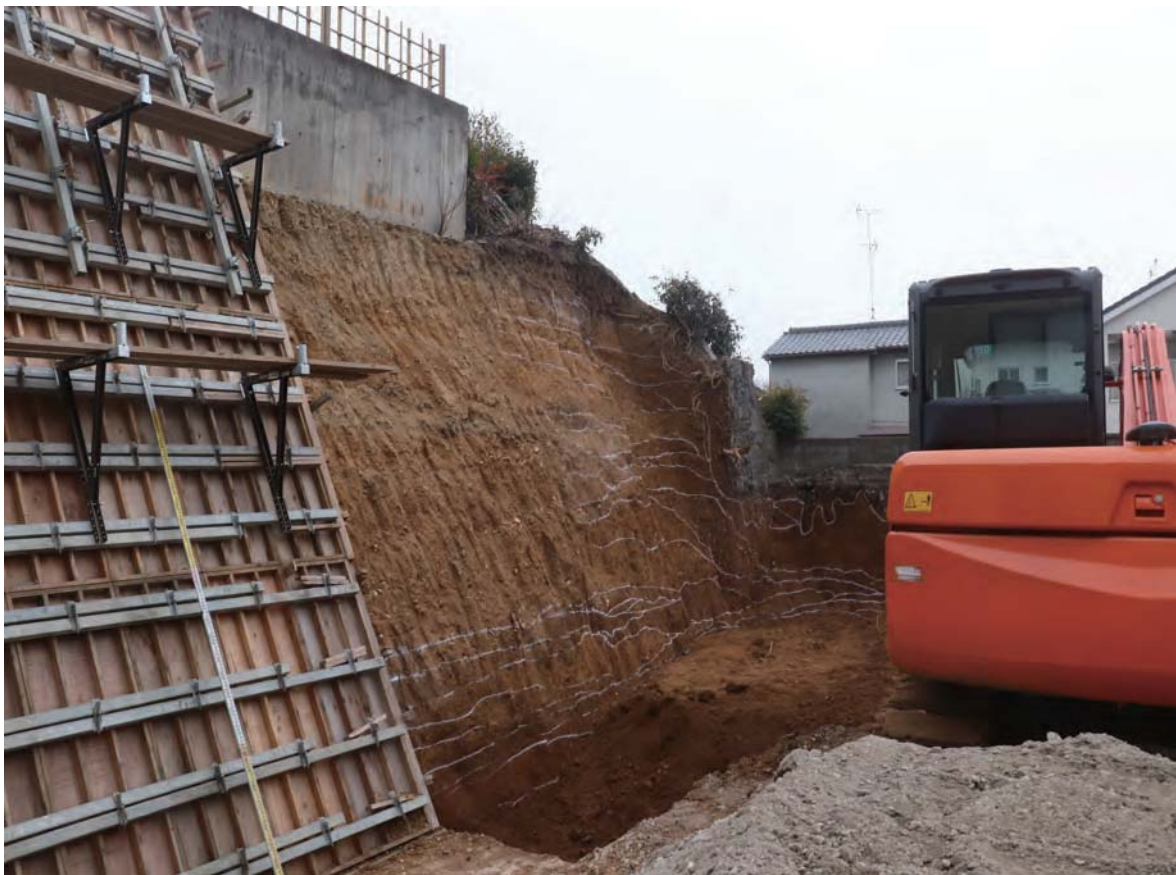
2 No.3～6 遠景 (北西から)
