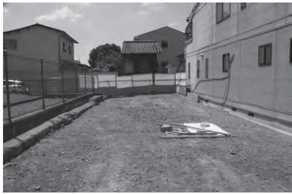
図5 埋め戻し完了風景（北から）
