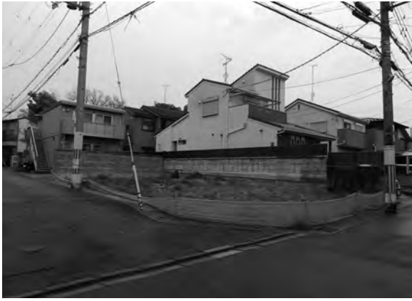
図2 調査前風景（南西から）
