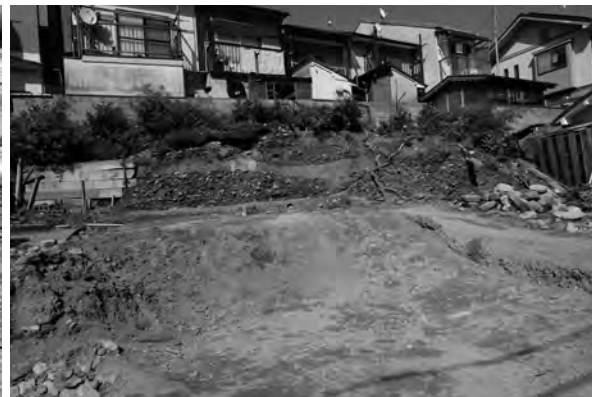
図7 埋め戻し完了状況（西から）
