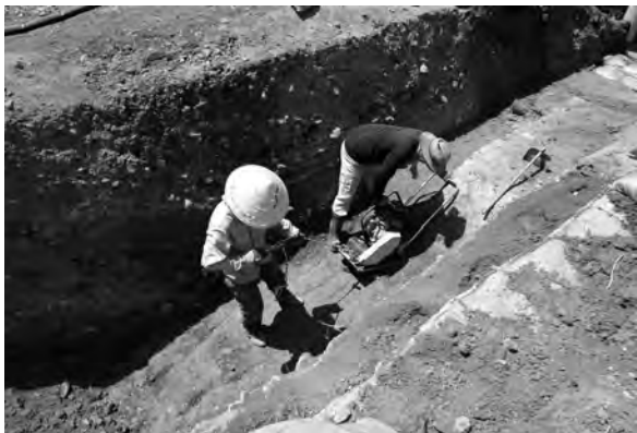
図6 埋め戻し状況（北東から）
