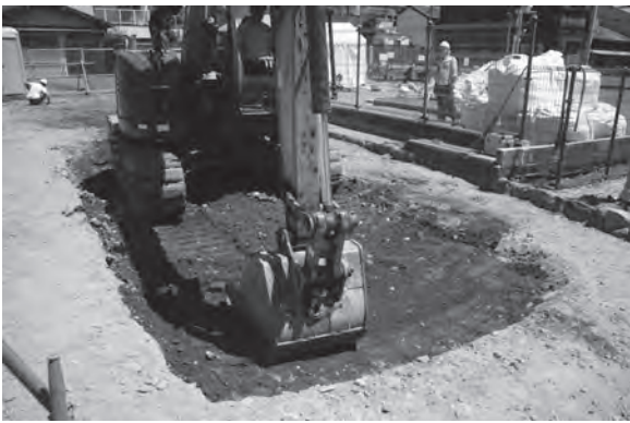
図4 埋め戻し作業（南西から）
