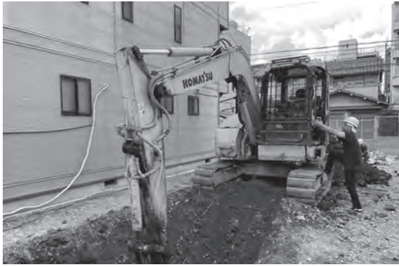
図2 重機掘削作業（南東から）
