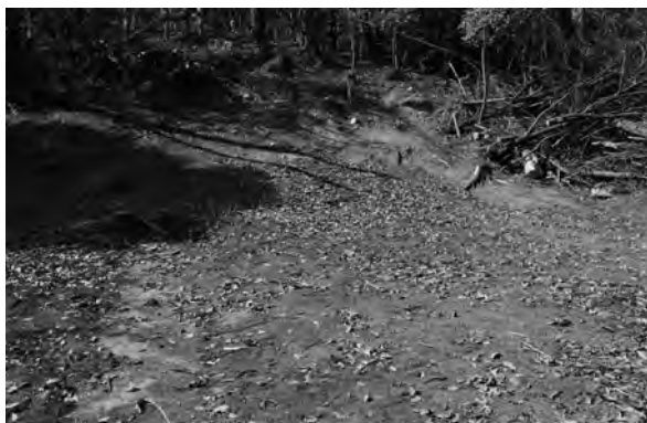
図4 3区埋め戻し完了状況（南東から）
