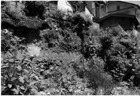
図2 盛土露出状況（北西から）
