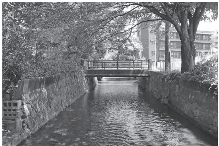
図23 高瀬川再整備前【写真中央は旧吾妻橋】(南から)
