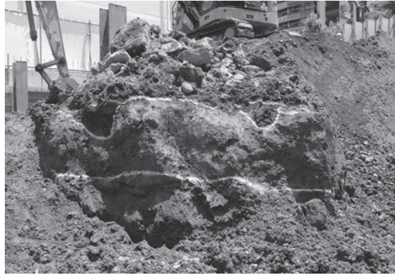
図18 No.5地点断面（北西から）
