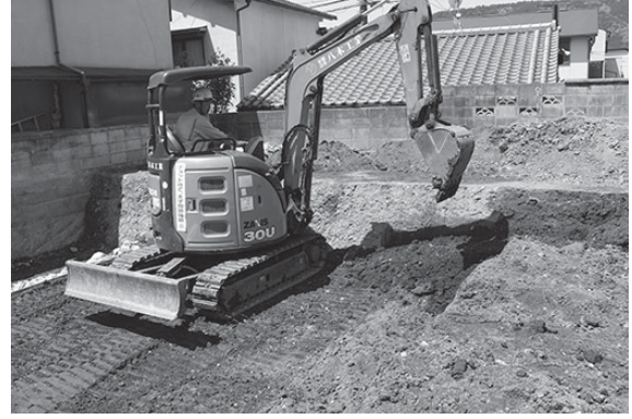
図3 2区重機掘削状況（北東から）
