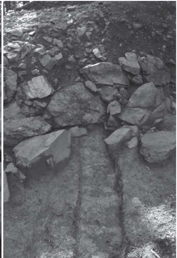
3 西櫓台北面石垣基底石据付状況（北から）
