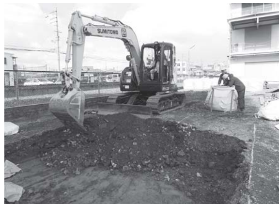
図3 重機掘削(南東から)
