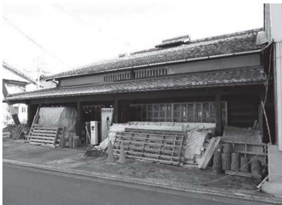
図2 被災前建物(南西から) 2)
