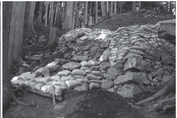
図7 西櫓台養生状況2（南東から）
