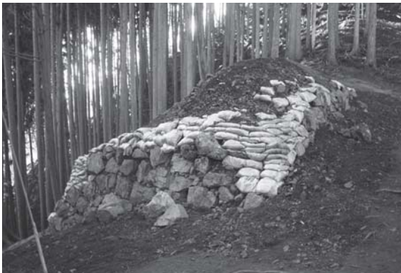
図6 西櫓台養生状況1（北東から）
