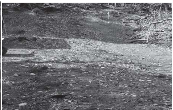
図6 1区埋め戻し完了状況（東から）
