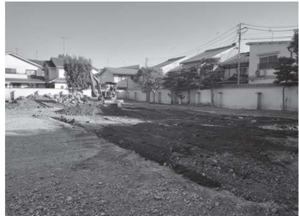
図5 埋め戻し風景（北西から）
