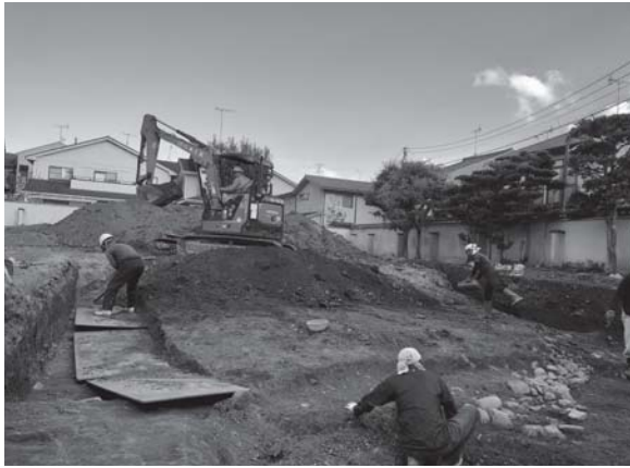
図2 重機掘削風景（西から）
