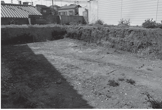
図2 調査前全景（南東から）
