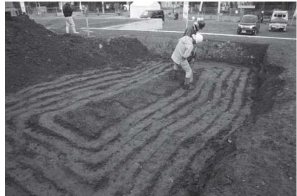
図5 1区埋め戻し状況（南西から）
