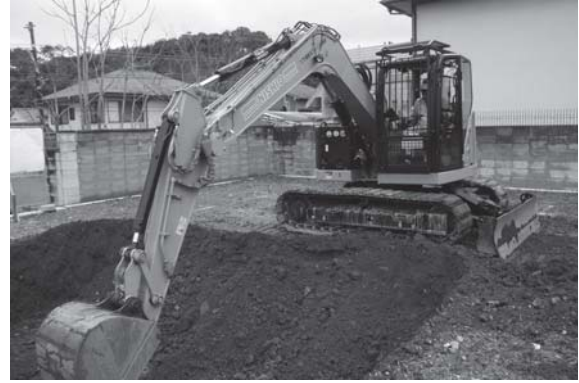
図3 1区重機掘削状況（北東から）
