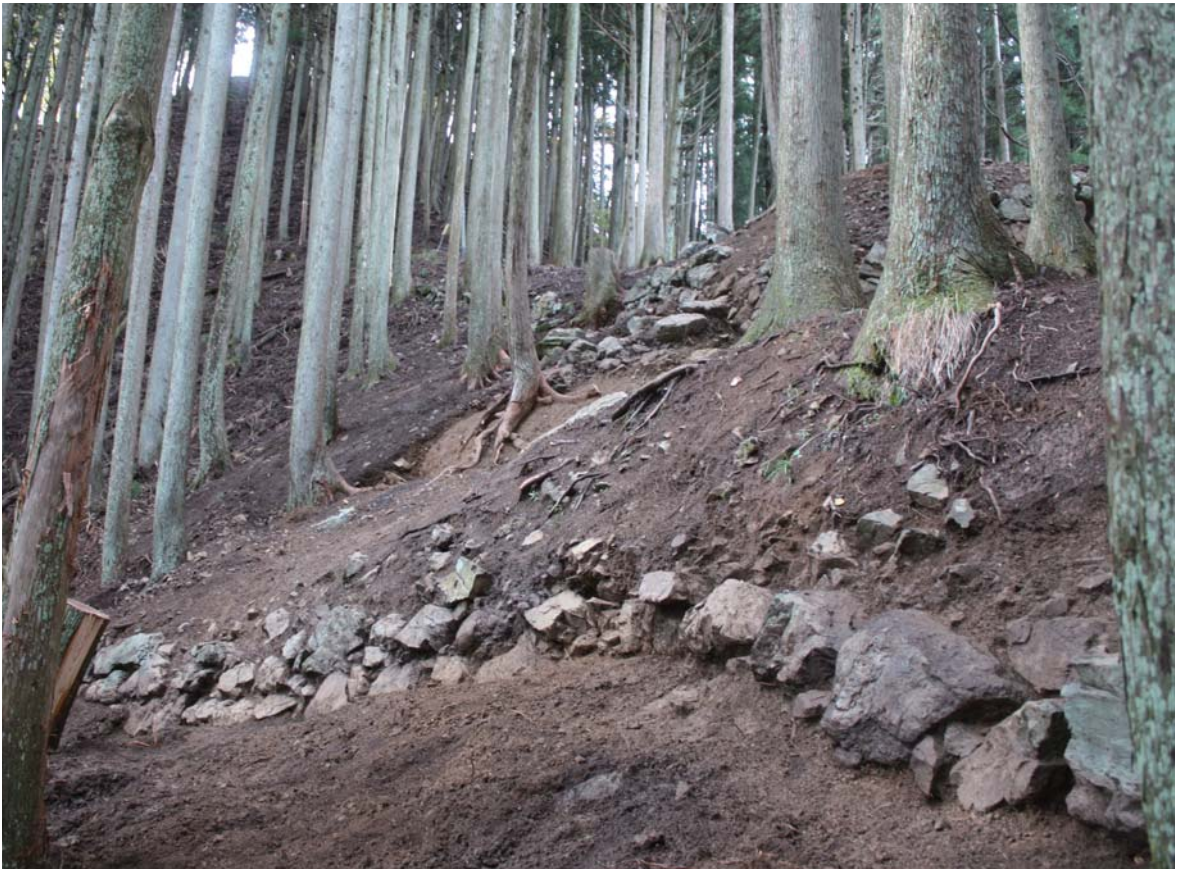
2 下段石垣と西櫓台（東から）
