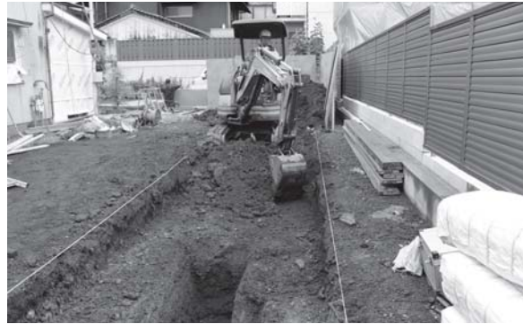
図2 重機掘削風景(南から)
