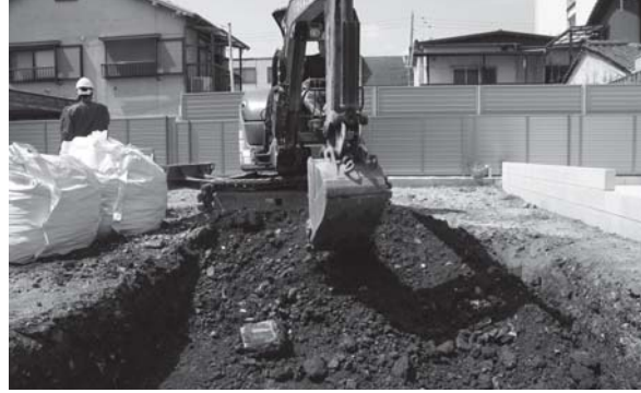
図3 重機掘削風景（北から）
