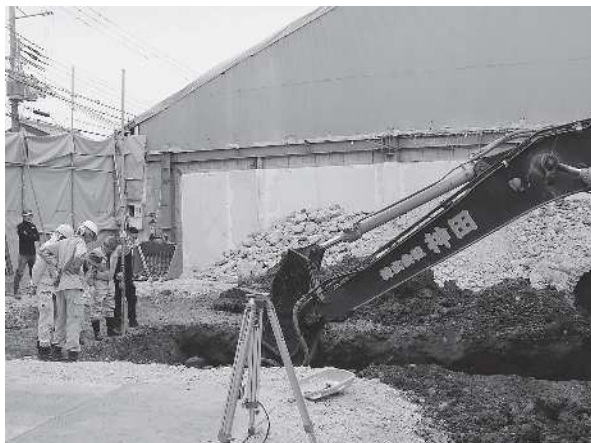
図4 重機掘削作業状況（東から）
