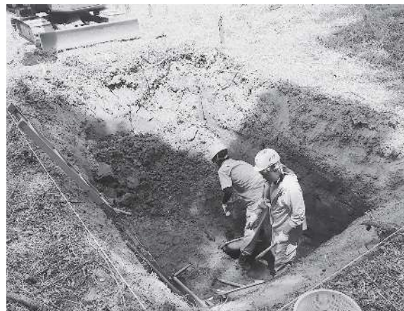
図5 人力掘削作業状況（南東から）
