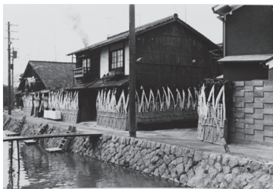
図 44 昭和 39 年 (1964) ごろの水車小屋外観
