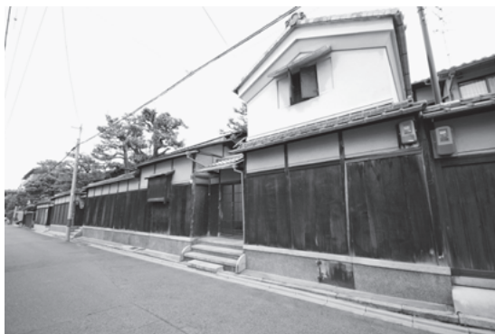
図 49 西川家住宅 外観
