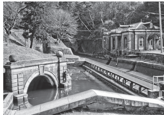
図4 琵琶湖疏水第3トンネル出口付近 右に見えるのが御所水道ポンプ室。左が第二疏水。
