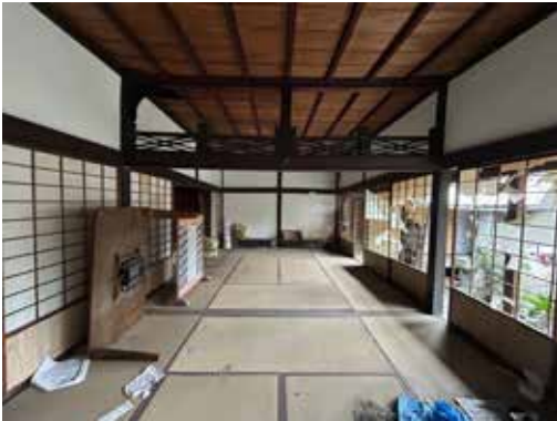
図23 10畳間と8畳間 東より西を見る
