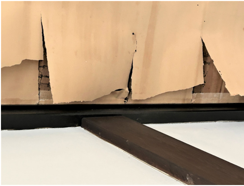
図21 天井 下張りが確認できる
