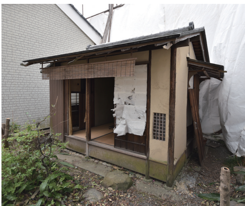
写真1 再発見時の外観 (北西から、2019/5/20撮影)
