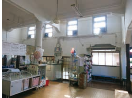
写真5 女性脱衣室から西面 ベビーベッドが並ぶ
