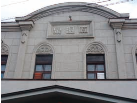
写真3 外観正面 看板建築
