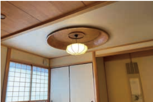
写真48 嵐山 遊月 客室 傘天井
