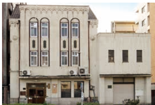
写真2 建物東面，2016年撮影
