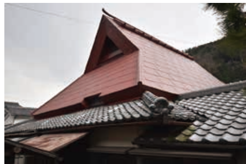
写真10 鉄板葺屋根の修理
