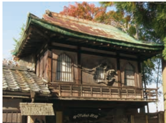
写真3 楼門 外観南面2階
