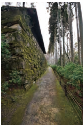
写真82 紙屋川庭園石垣
