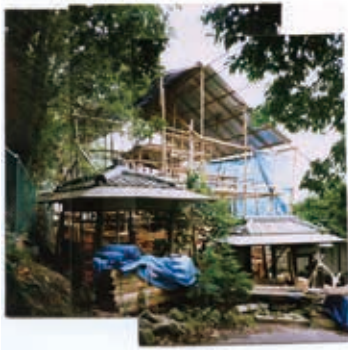
写真69 建設中の銅閣
