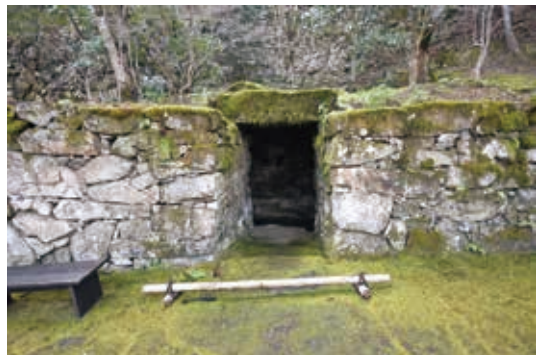
写真83 紙屋川庭園石室風貯水施設
