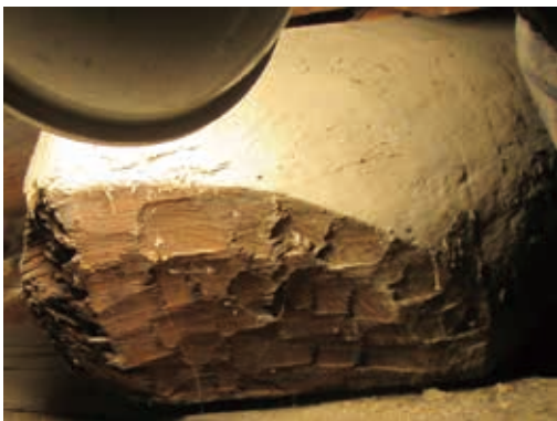
図10 内陣棟と外陣棟を繋ぐ桁材
