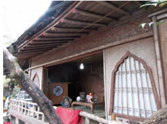
写真7 客殿 外観東面
