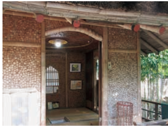
写真15 御殿 1層目外観西面(出入口)
