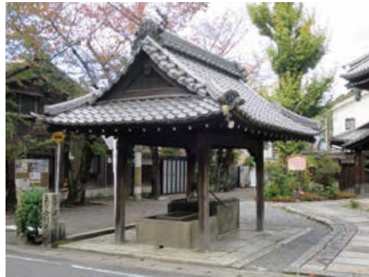
図25 井戸屋形全景
