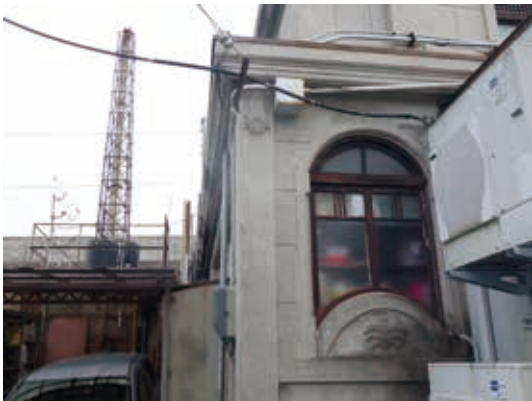
写真4 外観正面 北側張り出し部分
