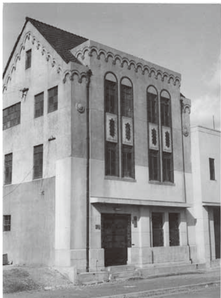
写真7 曳家工事完了後の辻商店旧建物
