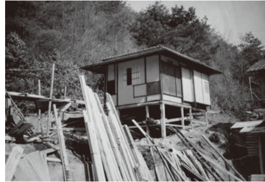
写真67 南方庵（移築工事中）
