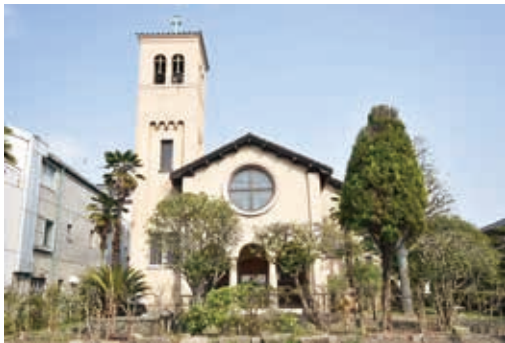
写真3 カトリック伏見教会
