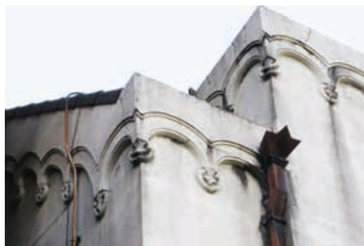
写真4 南東隅部，ロンバルディア帯と縦樋
