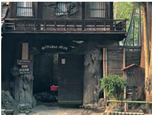
写真4 楼門 外観南面1階
