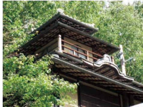
写真72 銅閣上層部分
