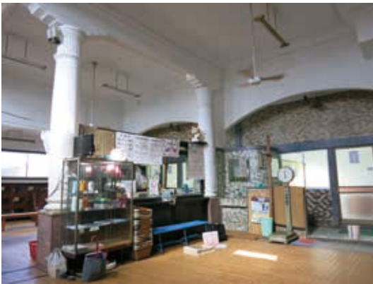
写真8 男性脱衣室から連結部分と北面
