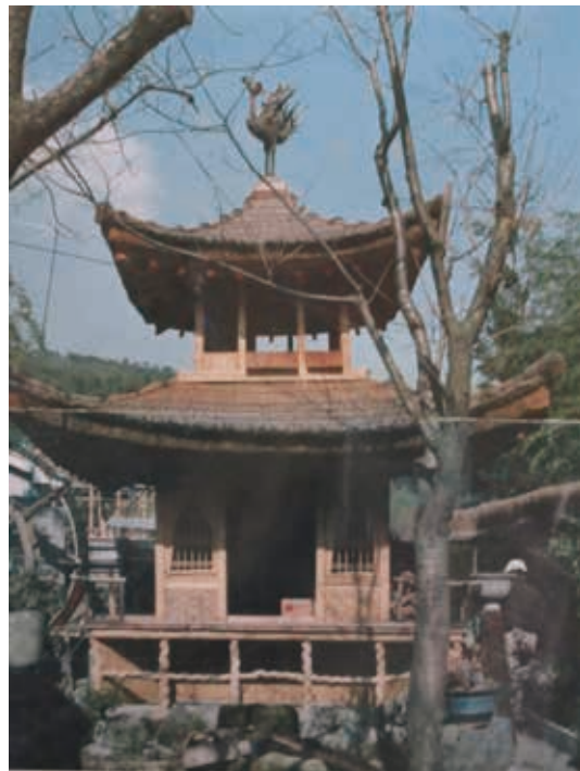
写真55 建設中の御殿 大工の姿が見える
