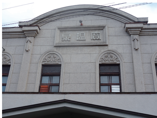
写真3 外観正面 看板建築
