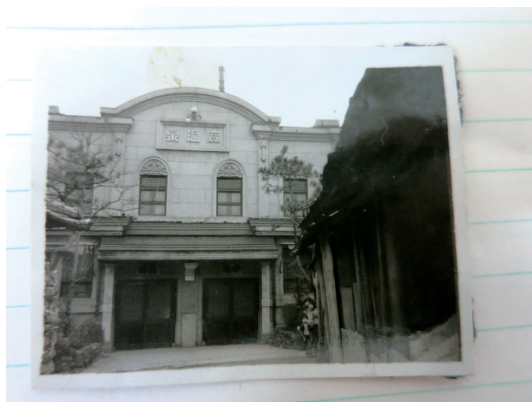
写真2 外観古写真（昭和6年頃撮影） 右の黒い建物はおが屑や廃材を貯蔵する燃料庫
