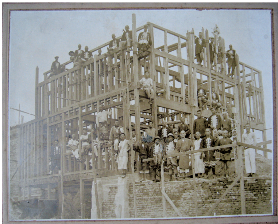
写真13 上棟写真 (昭和6年撮影)
