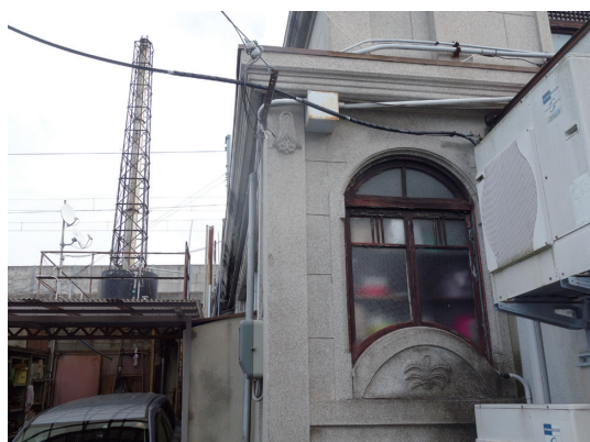
写真4 外観正面 北側張り出し部分
