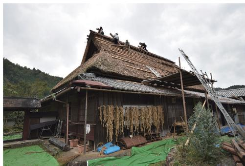
写真9 茅葺屋根の葺替え：河原林家
