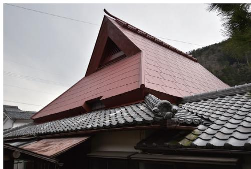
写真10 鉄板葺屋根の修理
