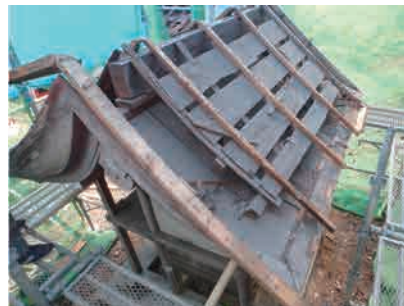
図14 若宮社屋根解体
