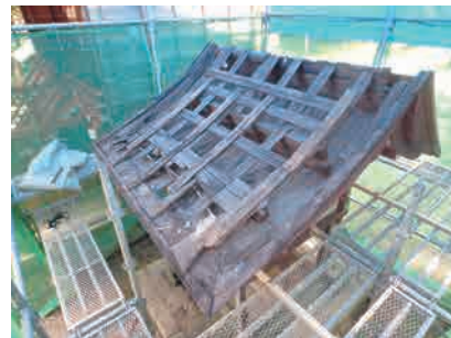
図10 柳社屋根解体
