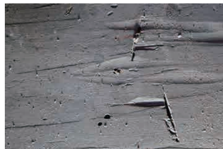
図12 柳社床板の台鉋と檜鉋様の痕跡
