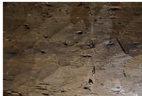
図6 田中社南側板の鉋の痕跡
