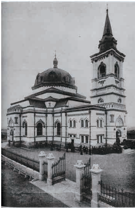
写真4 東京復活大聖堂(竣工時)
