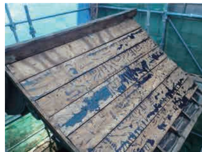
図8 田中社屋根解体
