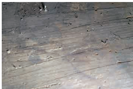
図19 稲荷社床板の台鉋の痕跡
