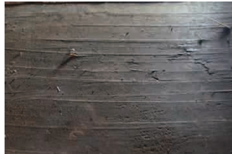
図4 田中社床板の台鉋の痕跡
