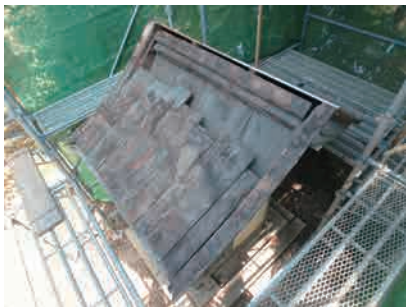
図17 稲荷社屋根解体
