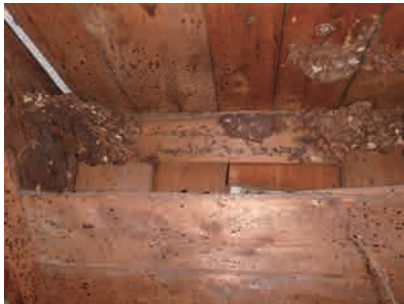
図3 田中社棟札取付き状況
