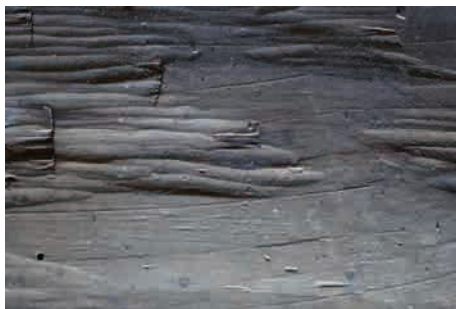
図5 田中社床板の台鉋と槍鉋様の痕跡
