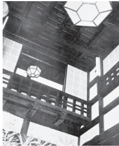
写真18 スエヒロ本店吹抜
