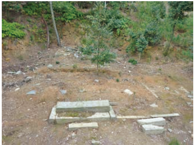
写真26 妙光寺 開山堂前堂礎石・延石・階段（南から）
