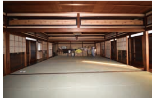
写真12 主棟部分 2階室内観
