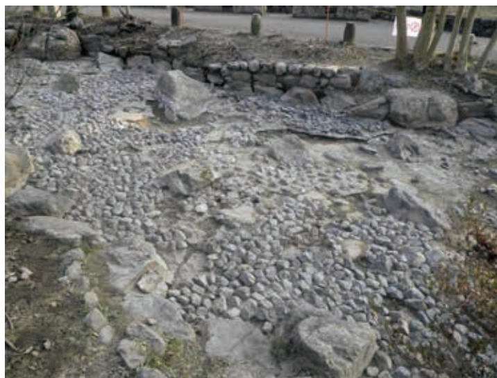
写真1 円山公園の流路底の石が欠損している状況（提供：植彌加藤造園株式会社）
