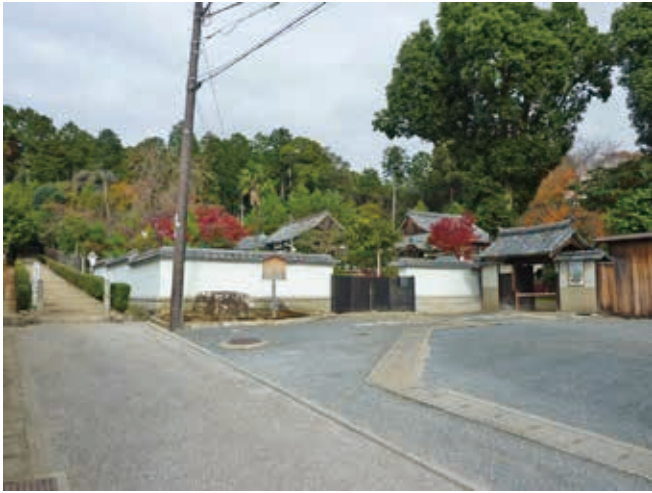
写真1 妙光寺境内正面（南西から）
