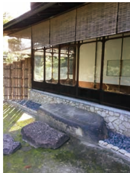
写真8 伏見稲荷松の下屋
