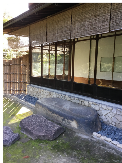
写真8 伏見稲荷松の下屋
