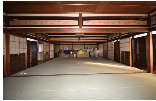
写真12 主棟部分 2階室内観
