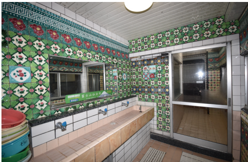
写真9 渡り廊下部分内観
