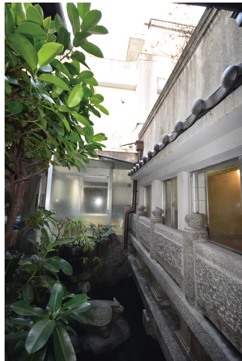
写真8 渡り廊下部分外観
