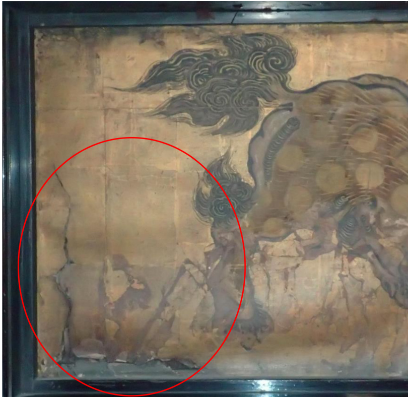
写15 修理前 中央 亀裂
