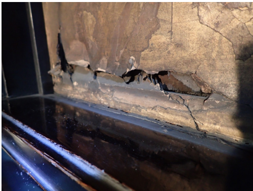
図10 取り外し前亀裂
