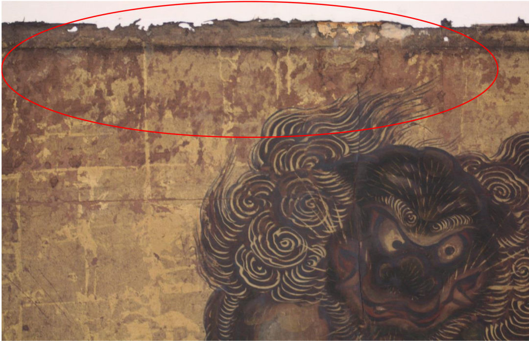
写27 修理前 東側
