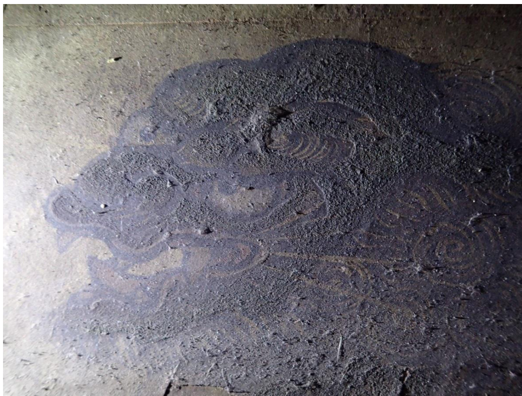
写29 修理前 東側
