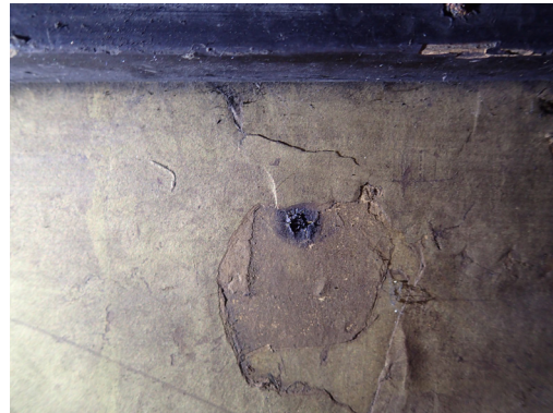
図11 釘錆による腐食
