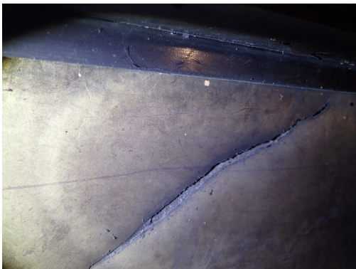
図12 取り外し前亀裂
