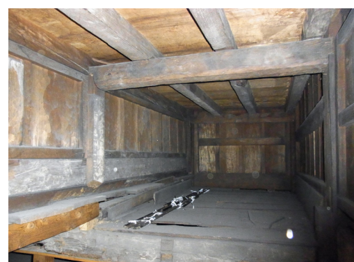
図18 仏壇下（西をみる）左側面が下地板
