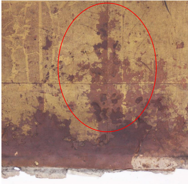
写23 修理前 東側 金箔地の剥落
