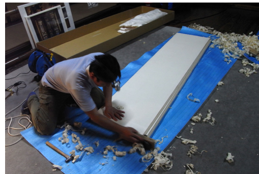
図16 建て合せ（現地にて微調整）
