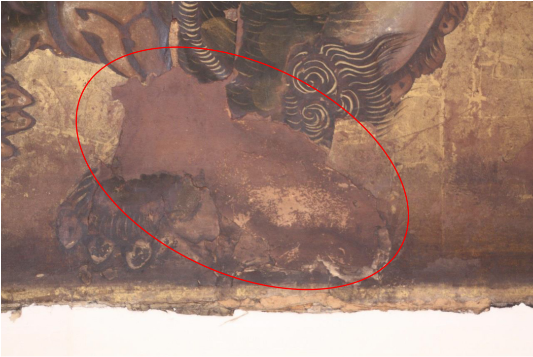
写25 修理前 東側
