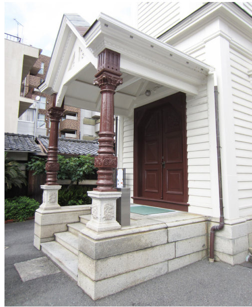
写真5 入口柱部分塗装
