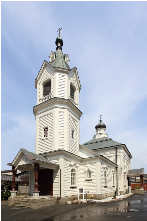
写真3 塗装修理後外観（2018年1月）
