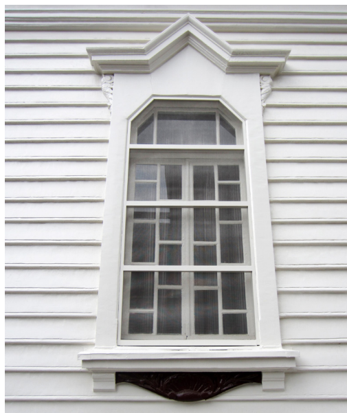
写真7 1階窓框下裝飾塗装（修理後）→
