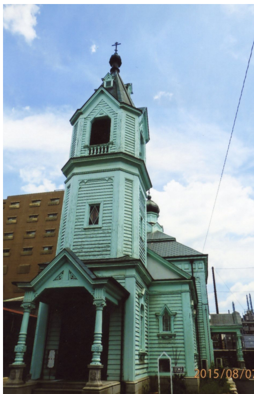
写真1 修理前外観(2015年8月)
